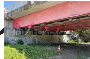
近年は劣化した橋も多くなり、地震や災害に際に橋が落ちないようにブラケットや緩衝チェーンを取り付け、皆様が通る橋を安全に保てるような工事を行っています。
